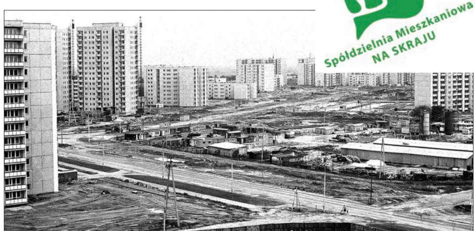
Ulica Cynamonowa w budowie, lata 1979-1980
