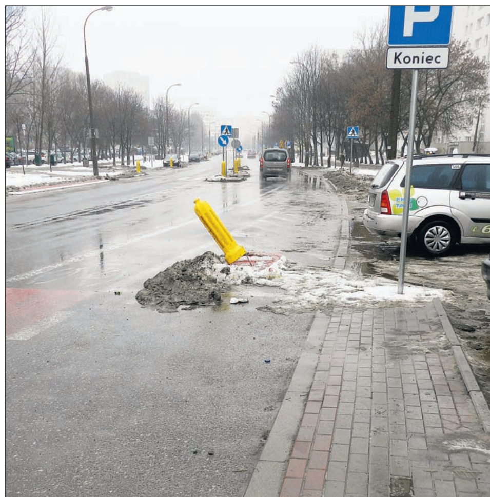
Cynamonowa po przebudowie
