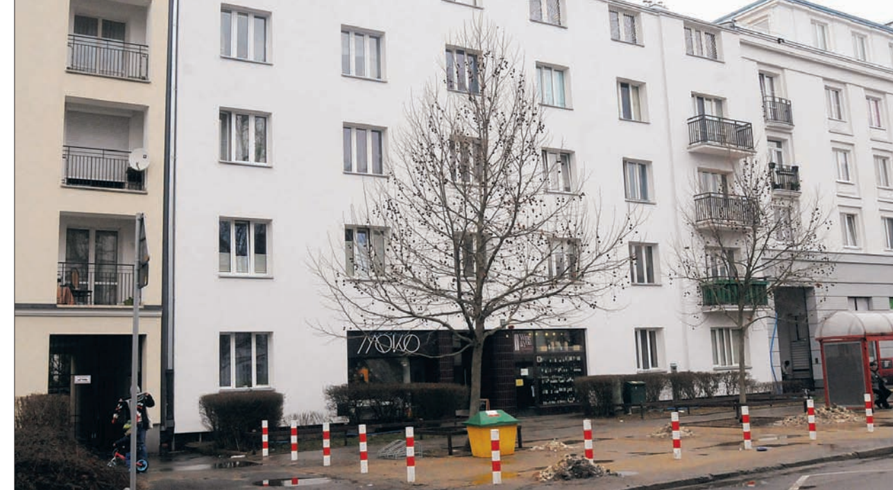
Budynek przy Malczewskiego 6
