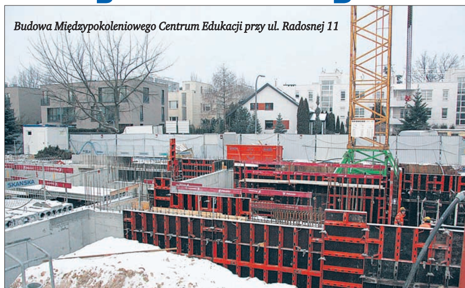
Budowa Międzypokoleniowego Centrum Edukacji przy ul. Radosnej 11
