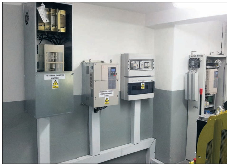
System zwrotu energii produkcji WINDA-WARSZAWA Sp. z o.o. w budynku Ministerstwa Skarbu Państwa
